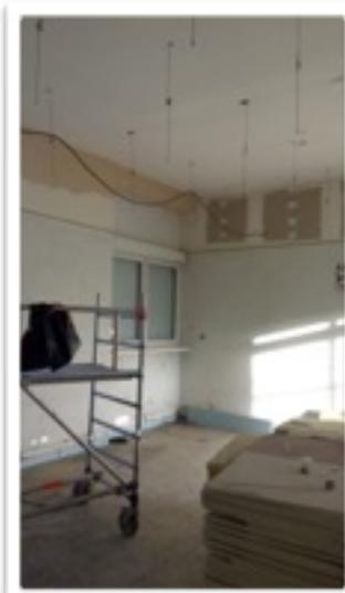
Le chantier est calme, seul l'électricien raccorde les nouveaux luminaires qui seront pilotés en fonction de la présence des élèves et de la luminosité extérieure.
